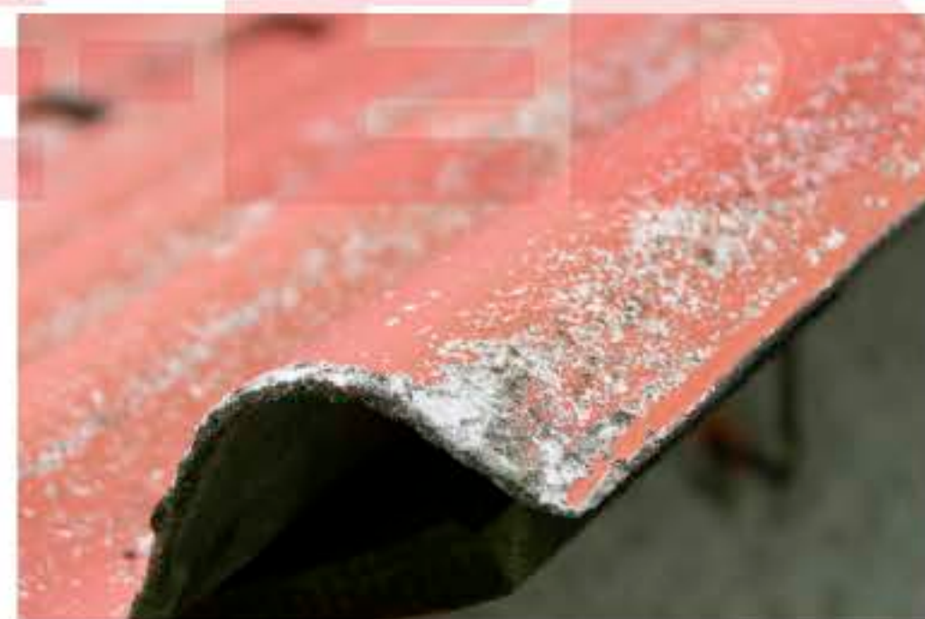
รูปที่ 1.9 หลังคาซีเมนต์ แอสเบสตอส
