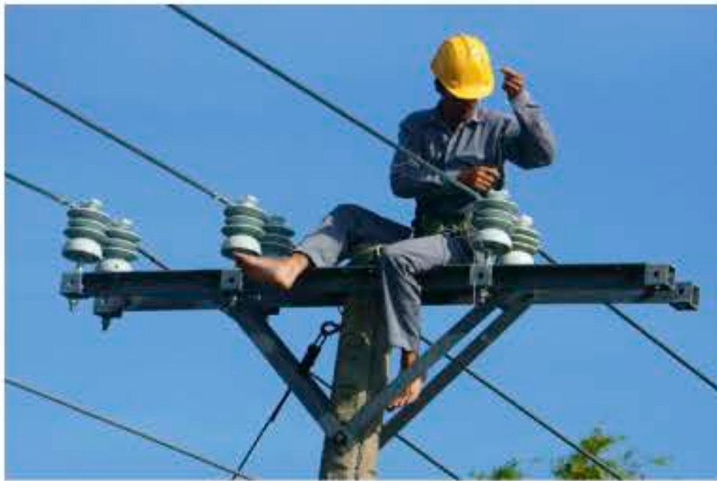
รูปที่ 1.19 การทำงานบนที่สูง
