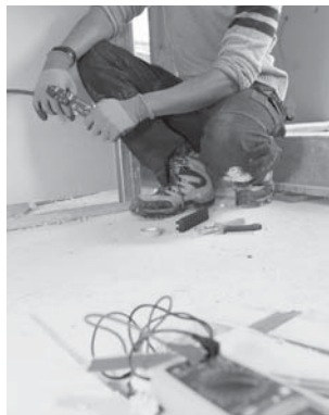
รูปที่ 1.17 สวมถุงมือและรองเท้าเมื่อปฏิบัติงานเกี่ยวกับไฟฟ้า
