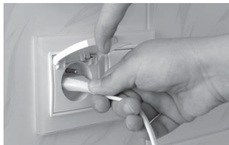
รูปที่ 1.15 เต้าเสียบภายนอกอาคารจะมีฝาครอบปิดกันน้ำและความชื้น
