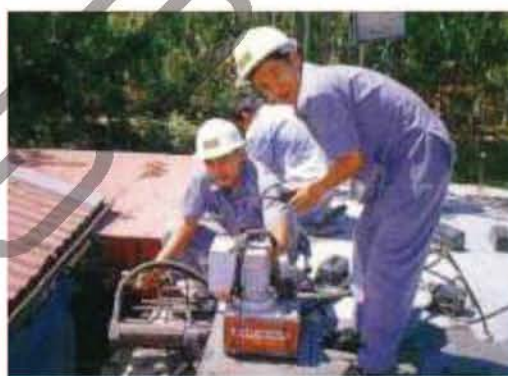
รูปที่ 4.127 ทำการดึงสลิงด้วยเครื่องไฮดรอลิกส์ให้ได้กำลังตามที่กำหนด
