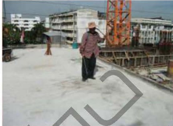
รูปที่ 4.125 การบ่มคอนกรีตด้วยน้ำ ยาบ่มคอนกรีต
