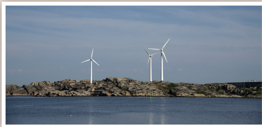
รูปที่ 6 การติดตั้งกังหันลมเพื่อผลิตไฟฟ้าบริเวณชายฝั่งของประเทศสวีเดน
