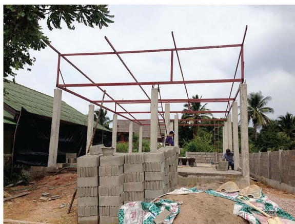
รูปที่ 1.8 งานก่อสร้าง (ที่มา : ผ่องพิศุทธิ์ ลาอุณ)
