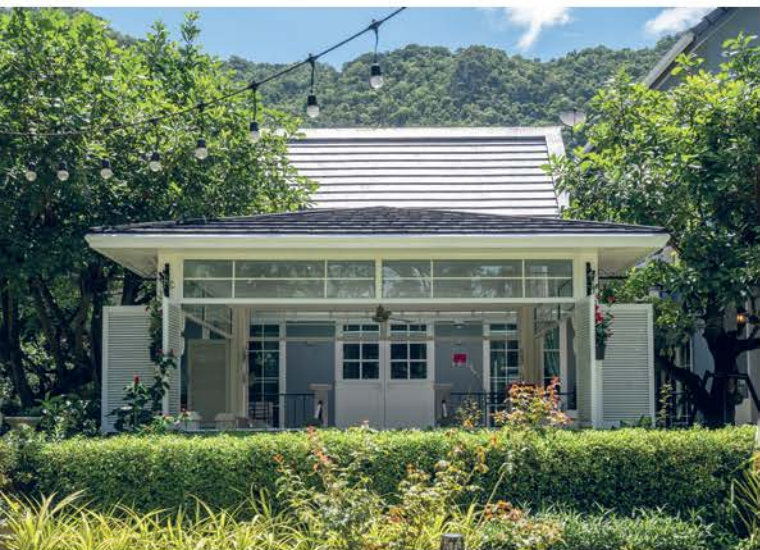
▲ ศาลาริมน้ำสวย น้ำถูกสร้างขึ้นเพื่อแก้ปัญหาแฉดร้อน
